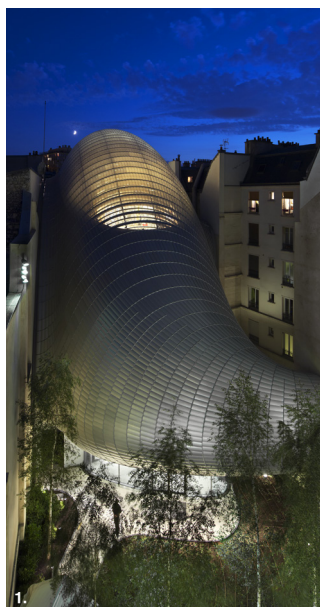
1. Vue arrière de la Fondation. 2. Espace de recherche.
