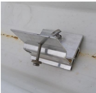
« Profilé de chéneau » avec boulon à tête marteau et vis autoforant
