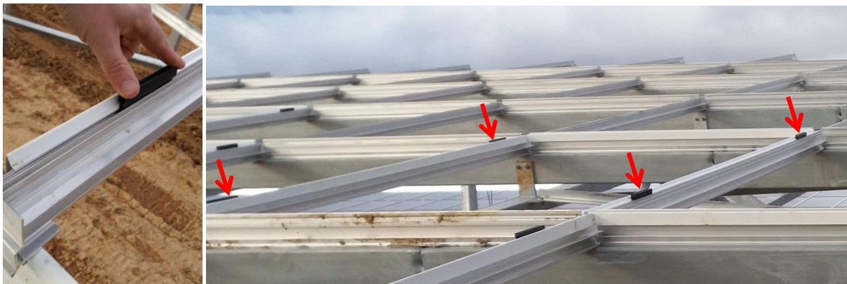
Placement des pièces en PVC
