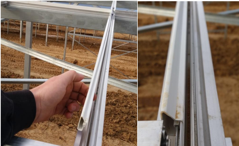
Placement des lattes en PVC
