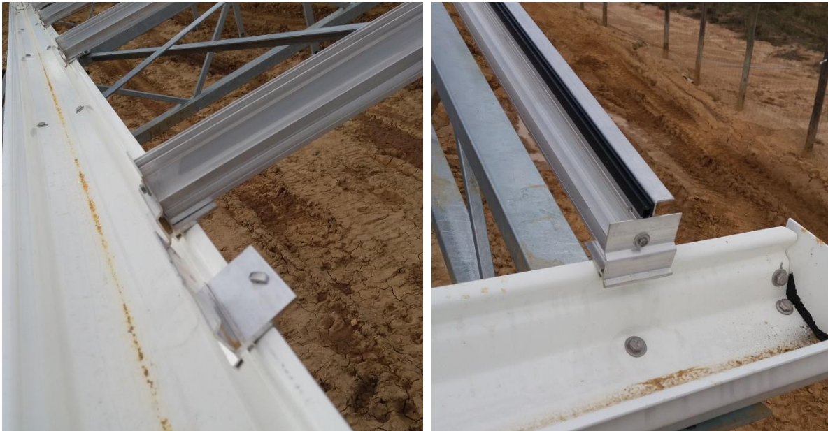
Pousser les « profilés de chéneau » sur le bord de la gouttière
