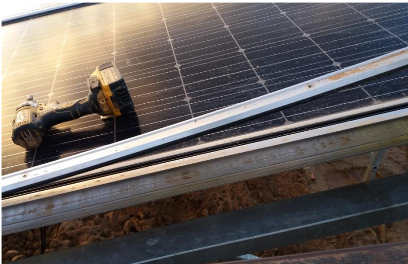
Fixation des « serreurs aluminium » sur les « lattes à verre ».
