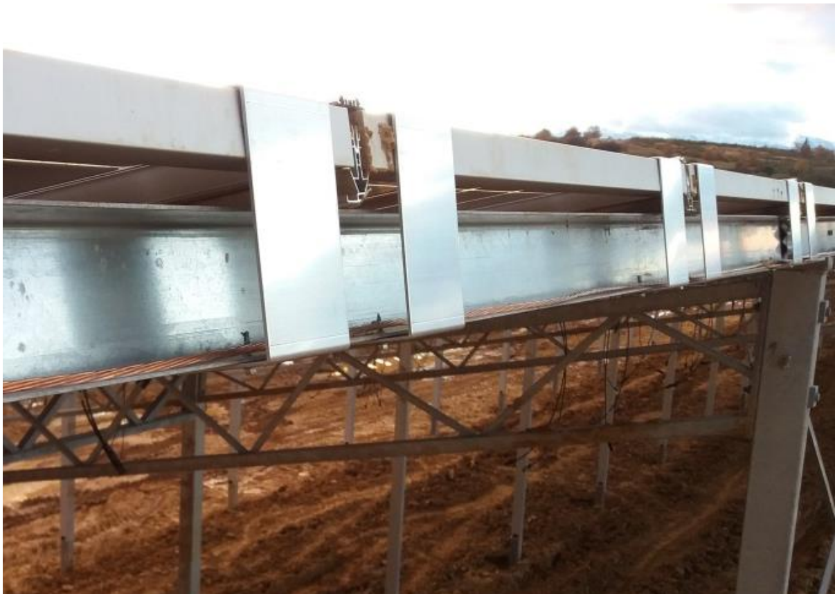
Fixation des « profilés de faîtage »
