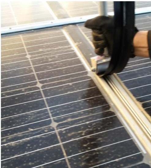
Insertion des « bandes en caoutchouc d'étanchéité »
