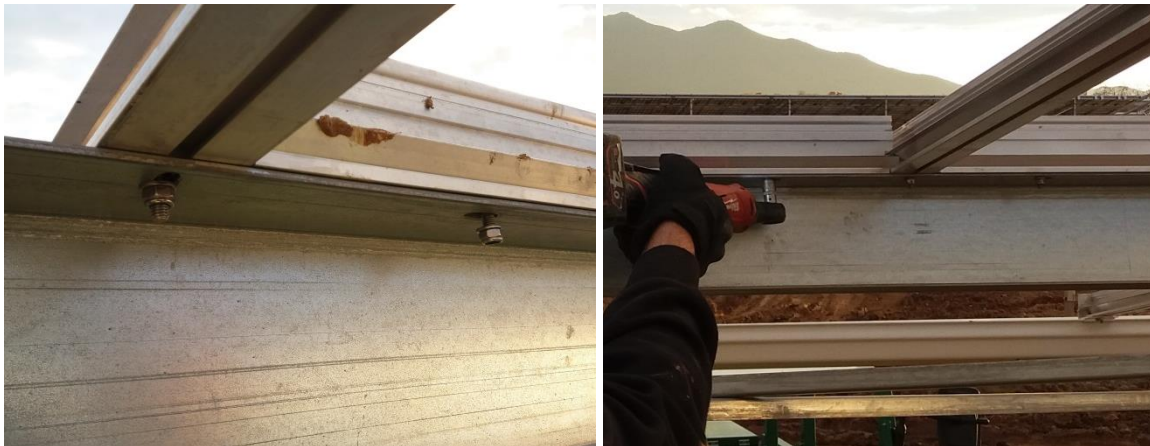
Fixation des « lattes à verre transversales »
