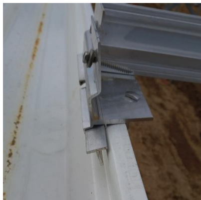
Glisser « profilé T 15x15x2 » dans le « profilé de chéneau »
