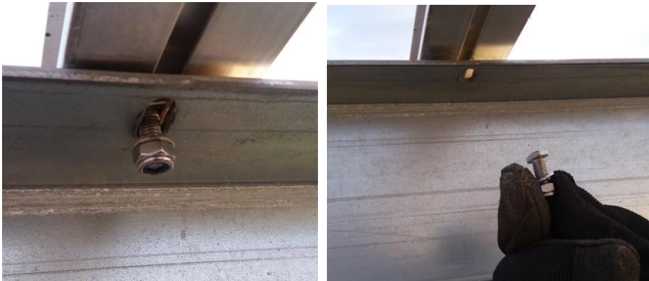
Fixation des « Lattes à verre » sur l'acier du toit
