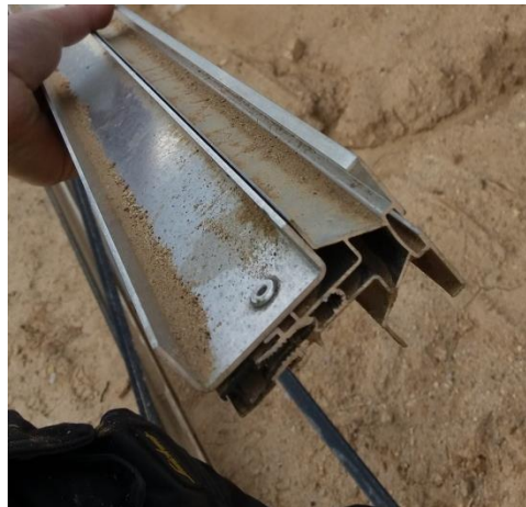
Fixation de « barre de terminaison latérale » sur la « latte à verre »
