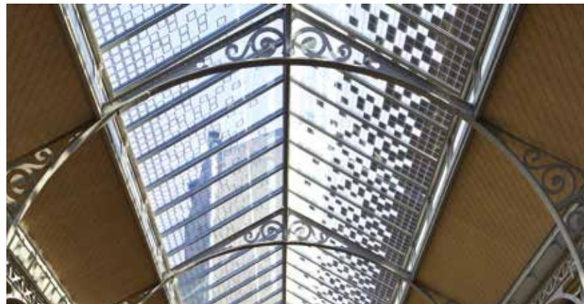
À droite le versant Sud-Ouest équipé de vitrages photovoltaïques, à gauche, le versant Nord-Est avec des vitrages sérigraphiés.
