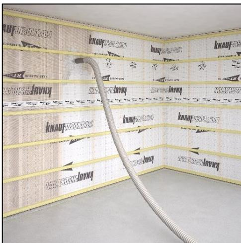
Figure 6 : Remplissage de la cavité
