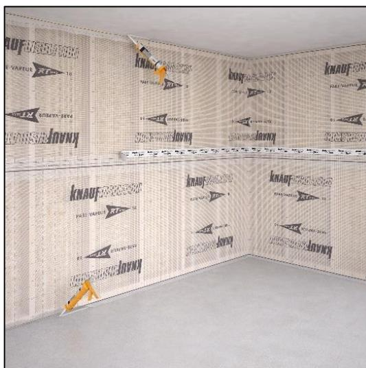
Figure 4 : Pose de l'adhésif et du mastic
