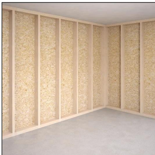
Figure 2 : Mur à ossature bois
