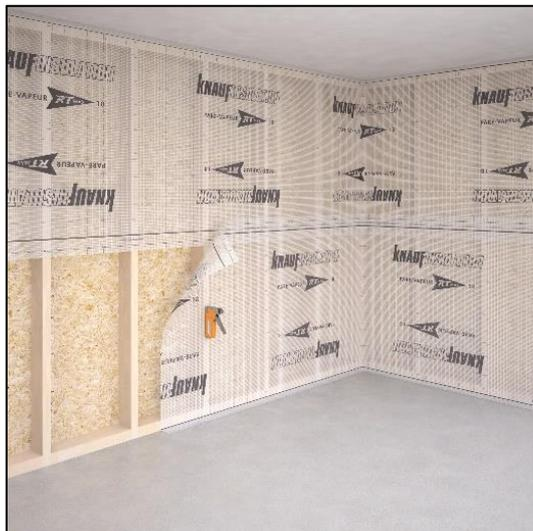
Figure 3 : Membrane pare-vapeur agrafée sur l'ossature bois
