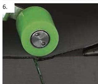
Dans le cas d'un joint en T, il est important de bien marquer le décalage d'épaisseur. La zone peut marouflée transversalement avec l'angle du rouleau.
