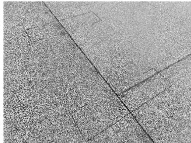
4- Chauffer la zone ainsi repérée à l'aide d'un chalumeau. Noyer les paillettes dans le bitume. Afin d'obtenir une bonne adhérence, il convient d'obtenir une remontée du bitume sur toute la surface préalablement définie
