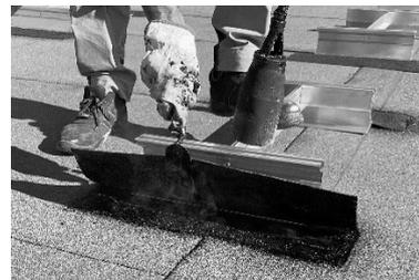
6- Pour souder la bande de raccordement pré-assemblée, il faut réchauffer la zone ainsi préparée à l'aide du chalumeau, chauffer la bande de raccordement extérieure, les mettre en contact puis maroufler toute la surface intéressée
