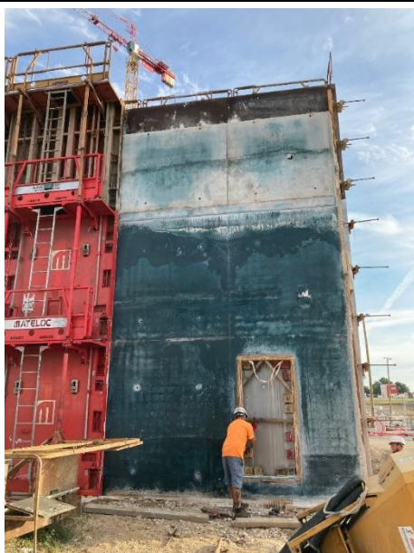
Teinte parement début de décoffrage
