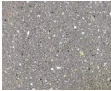
Figure 9 : Exemple d'état de surface de la chape poncée
