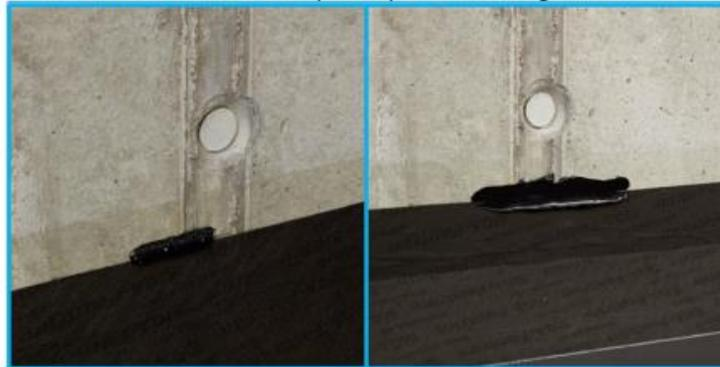
Etanchéité des pénétrations. Par exemple : sortie de gaine
