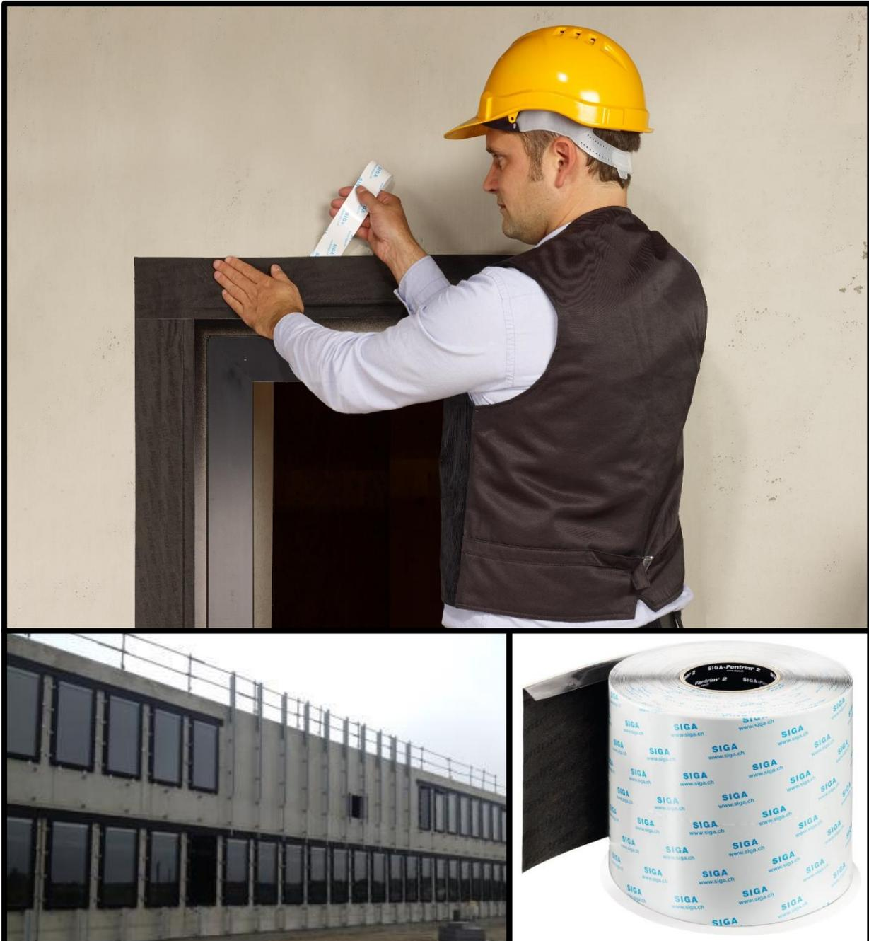
Système de calfeutrement des menuiseries et façades rideaux ou semi-rideaux sur le gros œuvre
