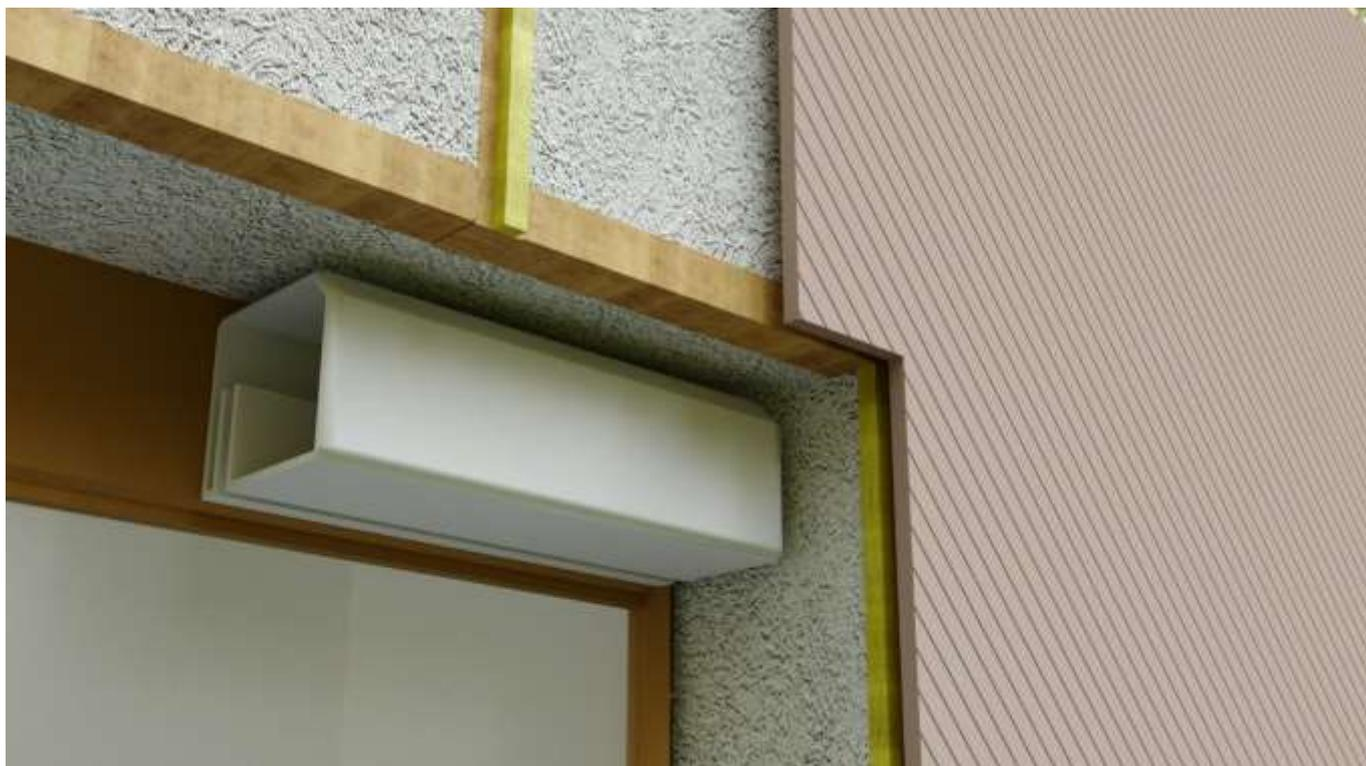
Figure 1 : détail retour isolant sur linteau et jambage fenêtre continuité thermique jusqu'au dormant de menuiserie avec volet roulant
