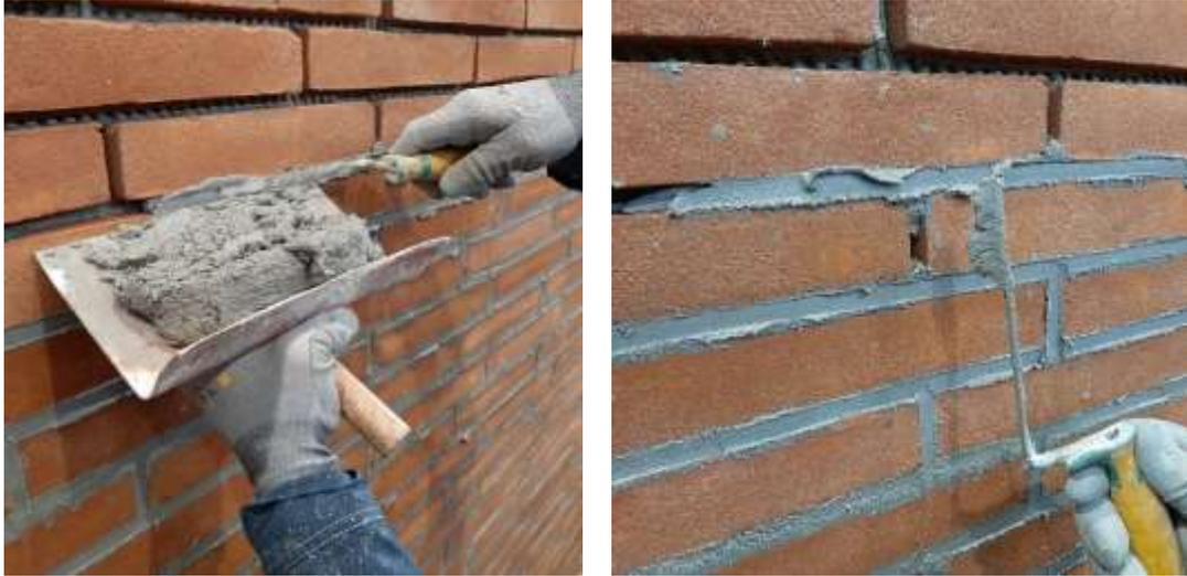
**Figure 5.** Jointoiment des plaquettes en terre cuite à fer à joint.
