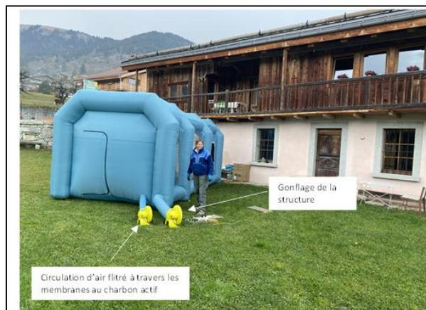
**Figure 19** : Espace de travail portable gonflable mis en œuvre à proximité du chantier
