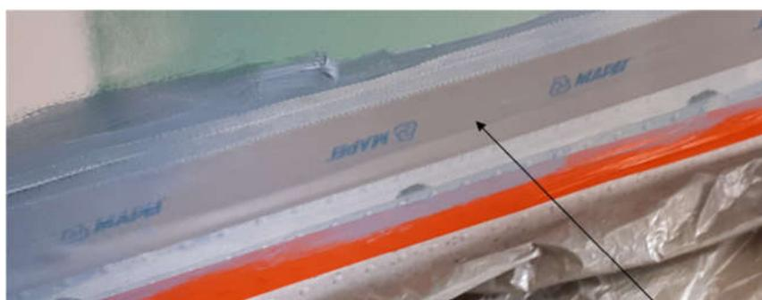
1<sup>ère</sup> passe et application des bandes pour étanchéité sur PVC / partie pleine
