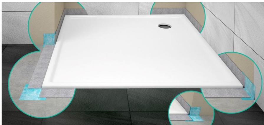
Figure 11 : Préparation du receveur avec le kit d'étanchéité – Positionnement et collage des angles 3D préformés
