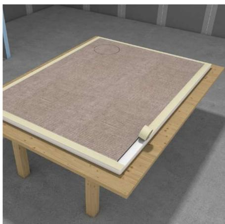
figure 2 et 2 bis : nettoyage et dégraissage de la tranche du receveur de douche et protection de sa face supérieure.
