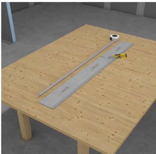
figure 7 : découpe des longueurs de bande étanche avec cordon de butyle.
