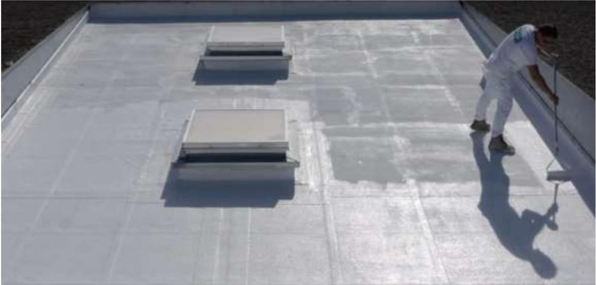
Photos 2 à 4 : Au-delà de 300m<sup>2</sup>, une machine Airless d'un débit supérieur à 5L/min
