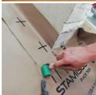
Variante : pour raccorder l'accessoire sur la membrane Stamisol PACK 500, il est également possible de thermosouder. Réaliser quelques points de soudure dans les 4 angles pour maintenir l'étanchéité bien en place puis souder comme décrit dans le chapitre 5.3.1 « Etanchéité des recouvrements en réalisant une thermosoudure ».
