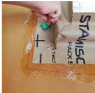
8/ Pour raccorder l'étanchéité sur la membrane Stamisol Extreme DW ou Stamisol Extreme PACK 500, en utilisant la Stamcoll N55, repérer l'emplacement de l'accessoire sur la membrane de partie courante en traçant un trait à 1 cm du bord, encoller avec Stamcoll N55 jusqu'au trait puis maroufler dans la colle liquide (A noter : bien agiter le bidon de colle avant chaque utilisation).
