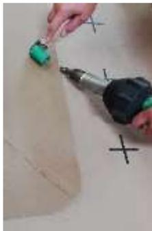
Variante : pour raccorder l'accessoire sur la membrane Stamisol PACK 500, il est également possible de thermosouder. Réaliser quelques points de soudure dans les 4 angles pour maintenir l'étanchéité bien en place puis souder comme décrit dans le chapitre 5.3.1 « Etanchéité des recouvrements en réalisant une thermosoudure ».
