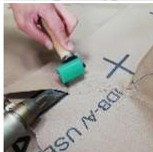
6 / Réaliser le raccordement en collant ou en thermosoudant, en veillant tout particulièrement au traitement des languettes dans les angles.
