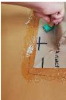
Pour raccorder l'accessoire d'étanchéité sur la membrane Stamisol Extreme DW ou Stamisol Extreme PACK 500, en utilisant la Stamcoll N55, repérer l'emplacement de l'accessoire sur la membrane de partie courante en traçant un trait à 1 cm du bord, encoller avec Stamcoll N55 jusqu'au trait puis maroufler dans la colle liquide (A noter : bien agiter le bidon de colle avant chaque utilisation).
