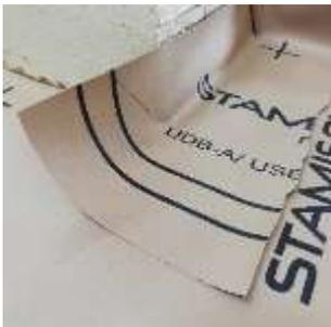
2/ Découper un morceau de lé de raccordement Stamisol PACK 800 ou une bande de membrane Stamisol Extreme PACK 500 (largeur 40 cm) de la dimension de la souche de cheminée + 15 cm, fixer la membrane sur la souche de cheminée avec Stamcoll N55, puis tracer un trait à 45° en partant de l'angle.
