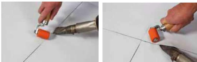
*Chanfrein réalisé à l'aide de la roulette (gauche) et soudure du joint en T (photo droite)*
