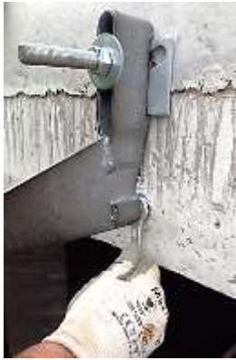
Photo 3: Réglage des consoles KORBO
