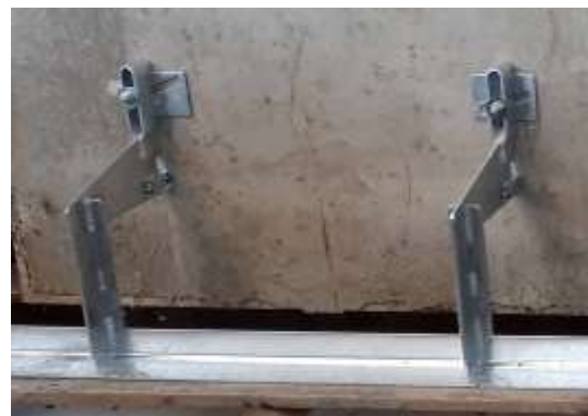
Photo 2 : Support de maçonnerie KORBO avec battée renforcée
