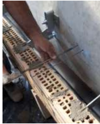
Photo 5: Installation des attaches murales avec l'outil
