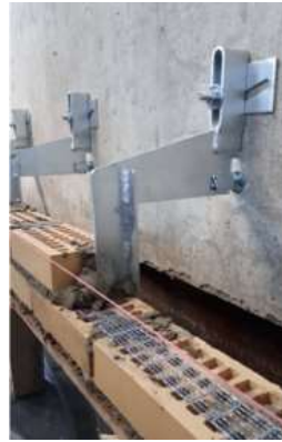
Photo 4: Premières rangs de briques
