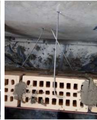
Photo 6: Attache murale droite avec bout plié
