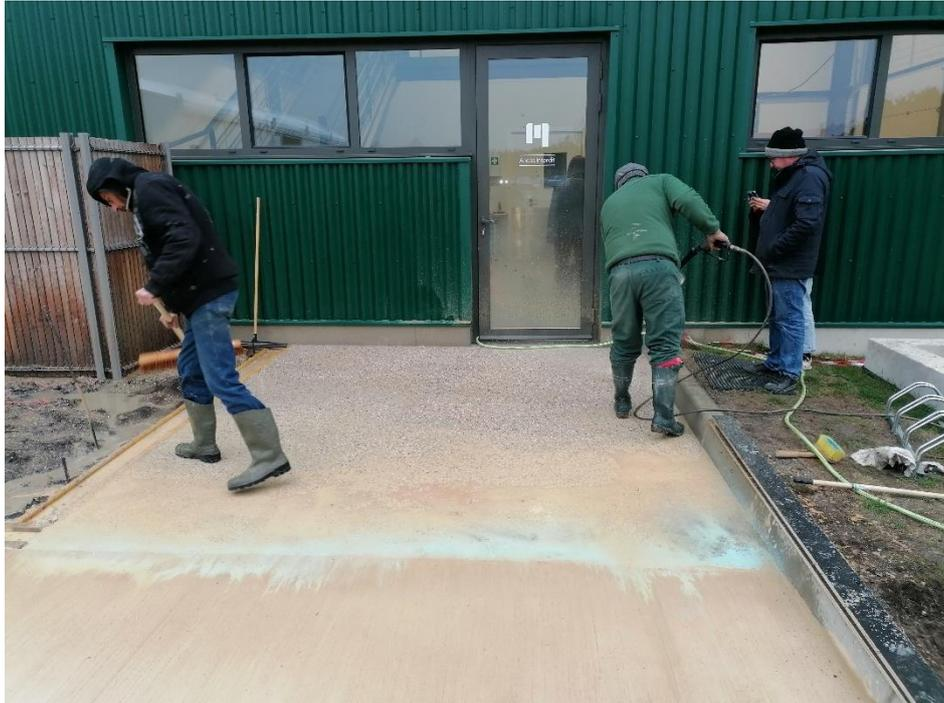
Coulage béton désactivé d'environ 2 x 10 m<sup>2</sup>
