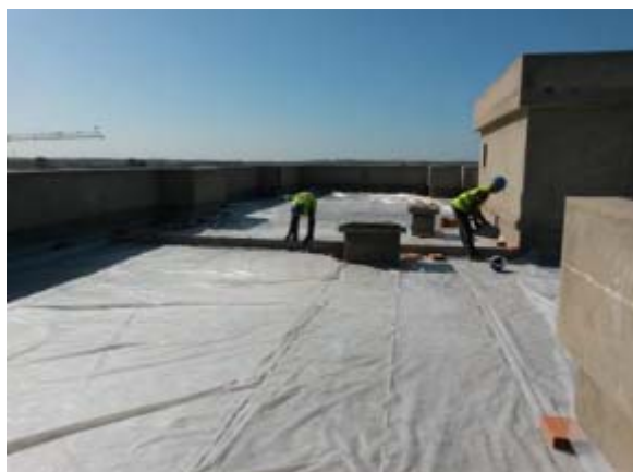
Préparation du chantier
