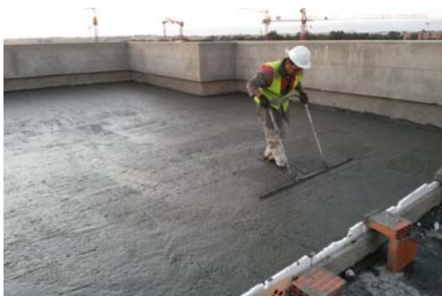
Surfaçage et mise en place de la pente
