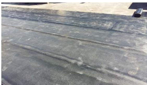
Mise en place de l'étanchéité
