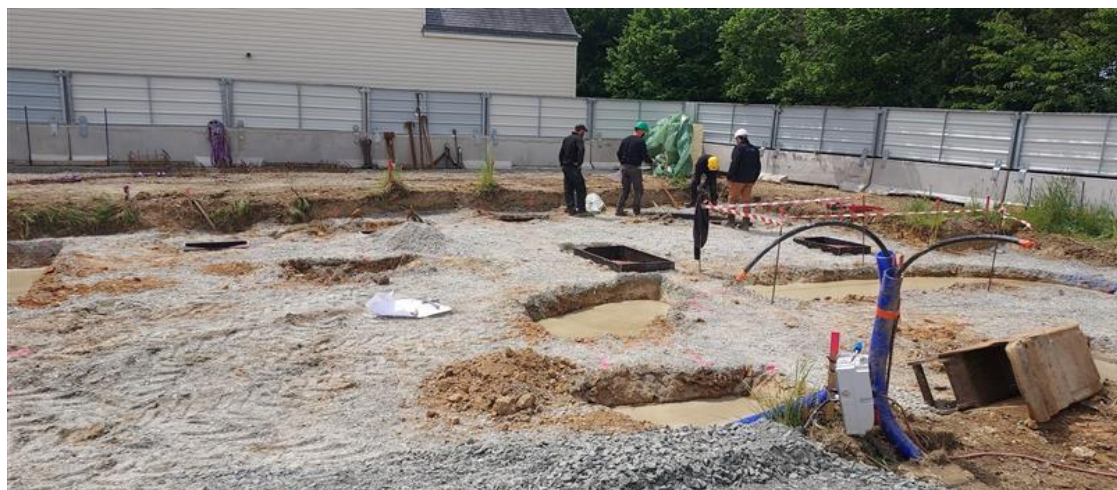
Photos du chantier Empreinte (en marron l'ensemble des bétons Anthropocite)
